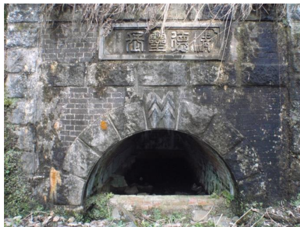
（隧道入口＝トンネルの内側も煉瓦積み）
