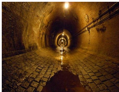
湊川隧道内部
