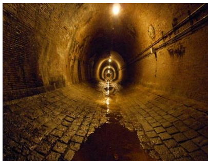
湊川隧道内部
