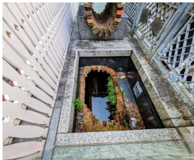
十五番館横の煉瓦造下水道
