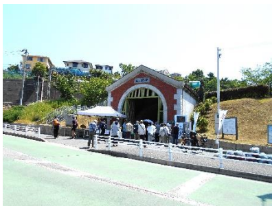
湊川隧道入口
