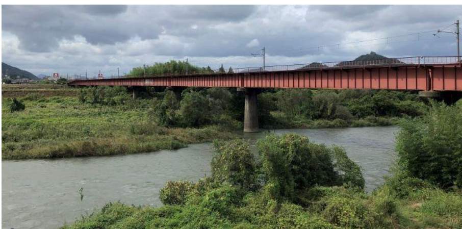
写真 24 昭和 38 年に架け替えられた現在の下由良川橋梁
