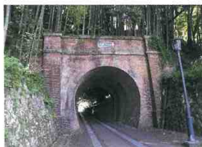
画像④中舞鶴線の北吸トンネル坑口
