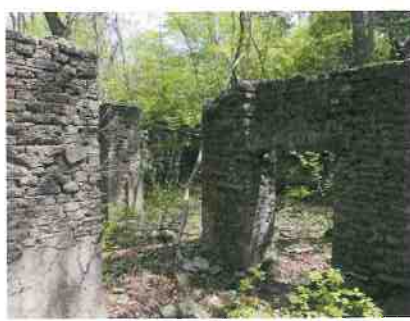
倉梯山防空砲台跡(セメント煉瓦造)
