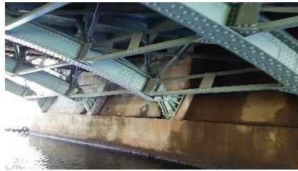
画像②真下から見る桜橋の下部構造
