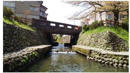
画像③水面近くから見る水路合流部
