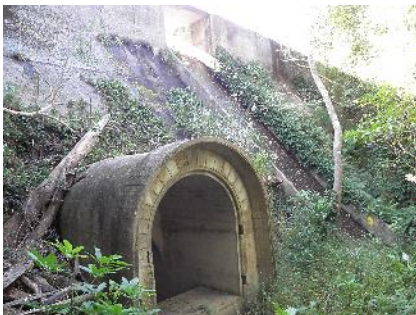
画像④海軍の艦船給水用ダムの堤体
