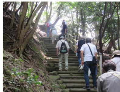
見学通路・木製階段整備
