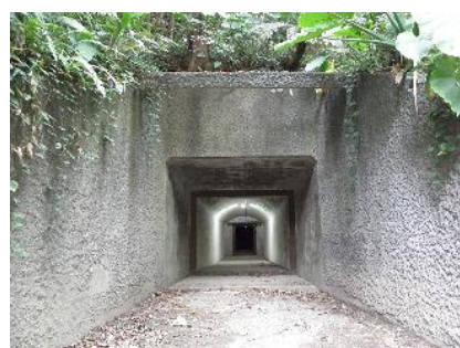
画像⑤内部が2重構造の弾薬庫入口
