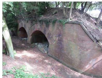
第一砲台跡（見学テラスより）
