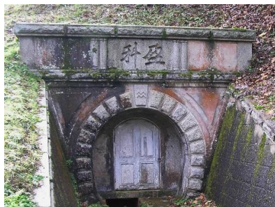
画像⑤岸谷川下流取水堰堤のトンネル
