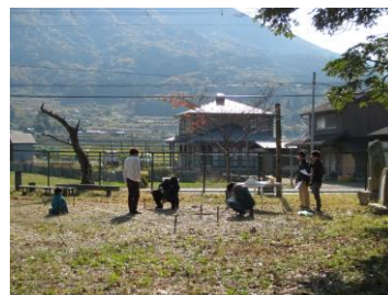
「みんなの小屋」予定箇所仮杭打ち
