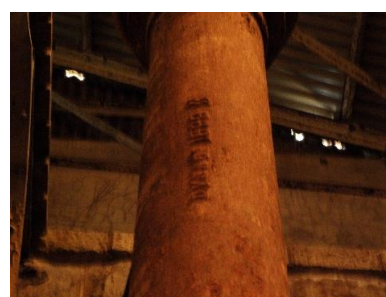
画像⑥北吸浄水場ろみ池内の鉄管
