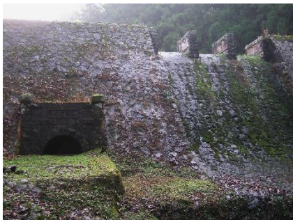
画像①下流側から見た桂取水堰堤
