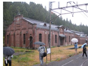
旧丸山変電所
