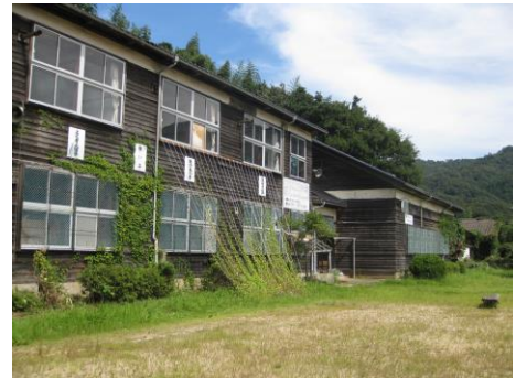
校舎内清掃・周辺樹木剪定作業ましま完了状況
