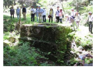
岸谷川上流日接合井(煉瓦造)
