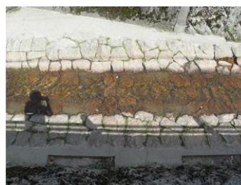
画像⑤榎川河床に敷かれた石材
