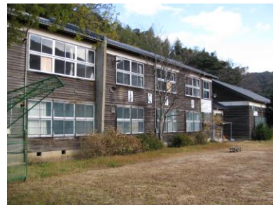
雨漏り修理、破損ガラスベニヤ仮修理完了
