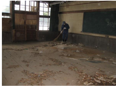
清掃状況(床はしっかりしている)
